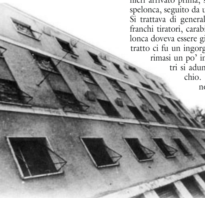
■ Via Tasso. Ala dell'edificio trasformato in carcere. Sono chiaramente visibili al 2°, 3° e 4° piano le finestre murate dalle SS e i minuscoli finestrini aperti per dare aria alle celle.
