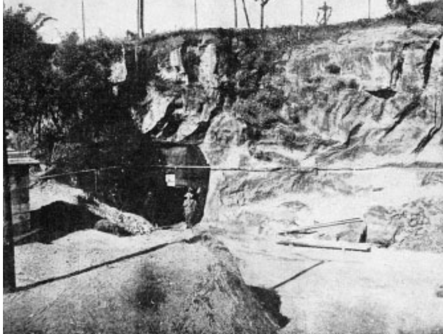
■ Uno degli ingressi delle grotte Ardeatine un tempo adibite all'estrazione della pozzolana.
