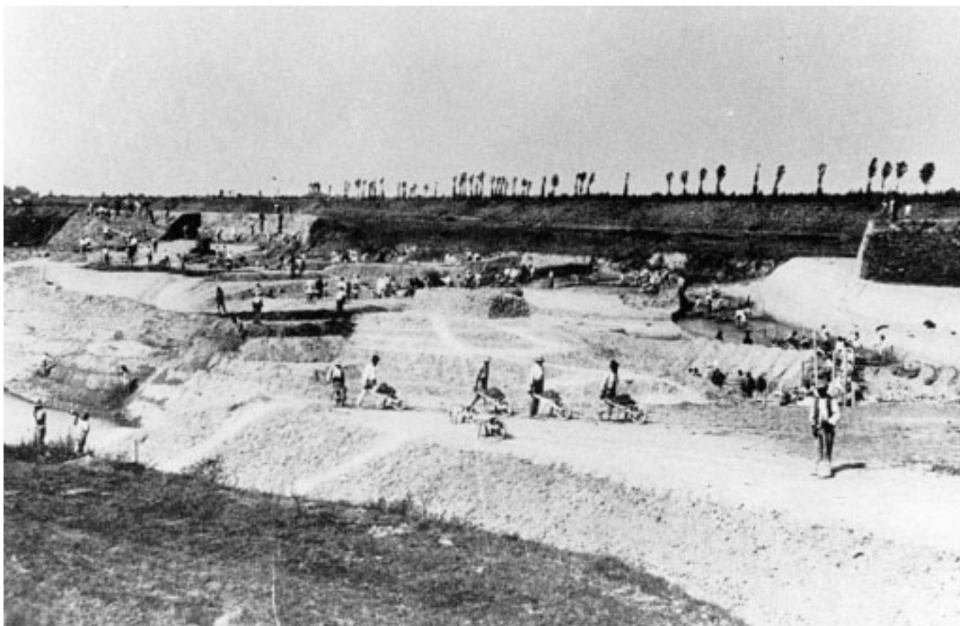
4. Gli "scarriolanti" al lavoro lungo gli argini del Po. Migliaia di operai, negli anni, hanno scavato intorno al grande fiume per rendere sicura la vita degli abitanti dei paesi e delle città che si affacciavano sulle rive. La foto è di autore ignoto ed è stata scattata probabilmente intorno al 1908.
