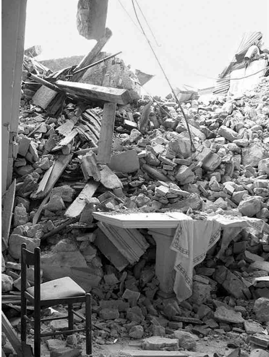
■ I resti della chiesa distrutta dal terremoto.
