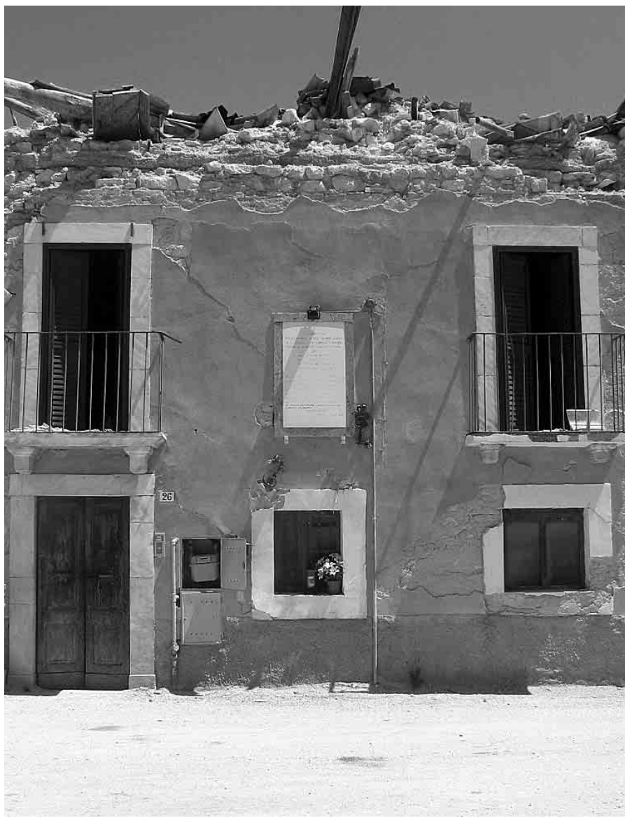
■ Sulla facciata della casa, prima distrutta dai nazisti ed ora dal terremoto, è stata ricollocata la lapide che ricorda la strage.
