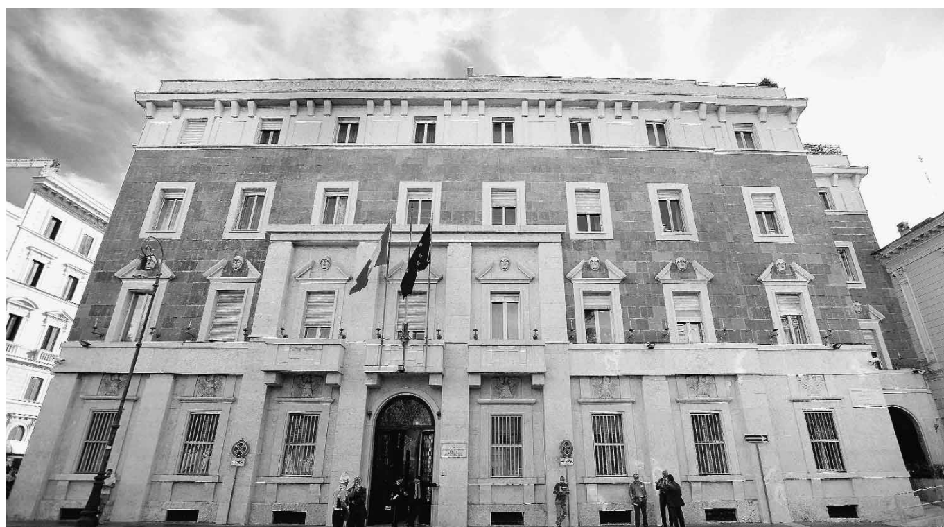
■ Sotto la pressione dell'esecutivo, si prospetta la "svolta epocale". Nella foto il Palazzo dei Marescialli, sede del CSM.
