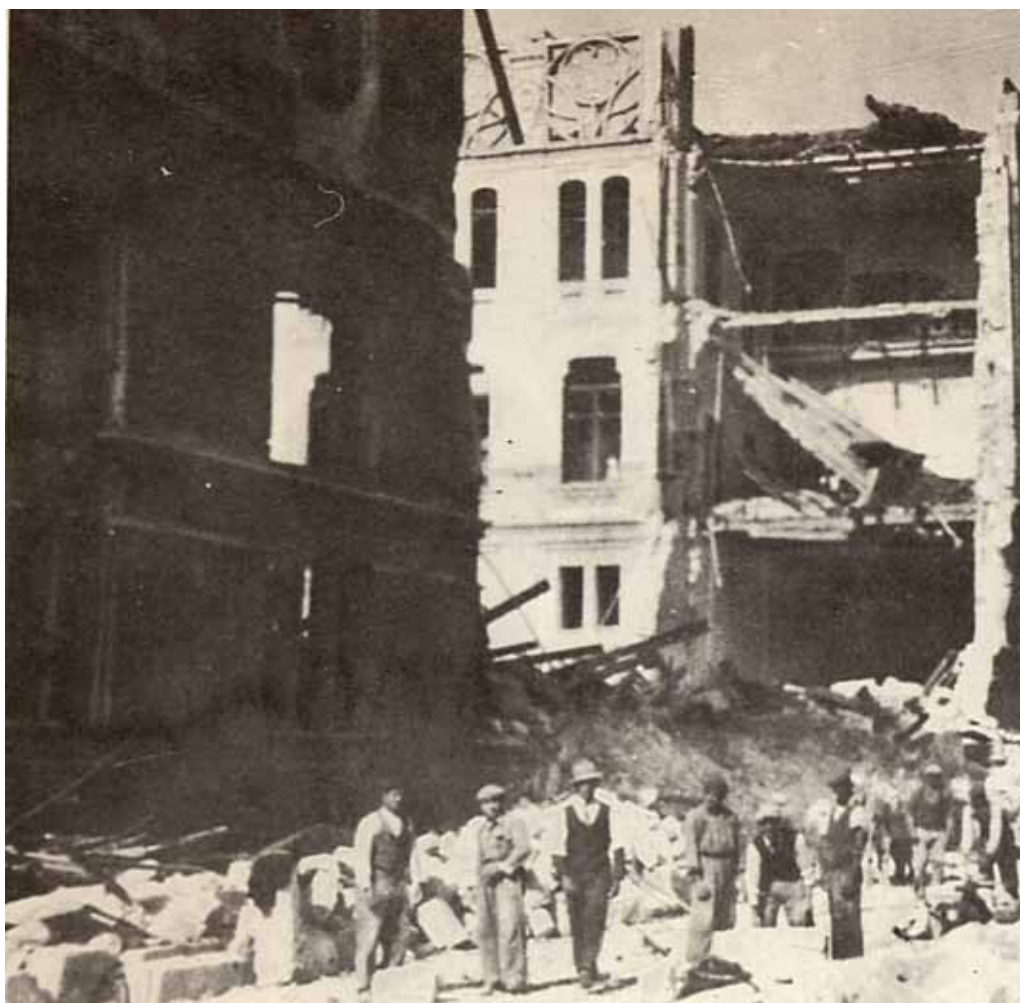
Via Crispi e il retro del Palazzo Comunale, nei giorni del bombardamento
