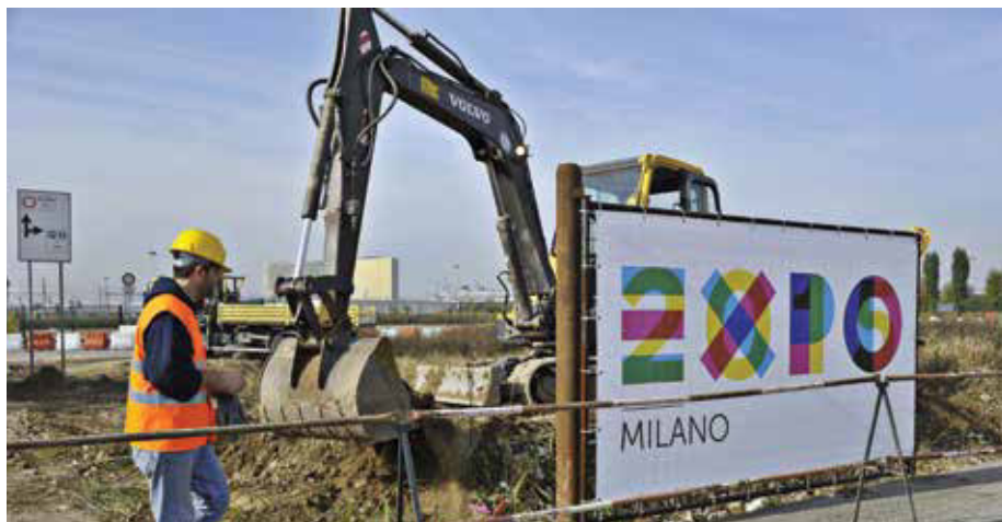
Il cantiere dei lavori per l'Expo
